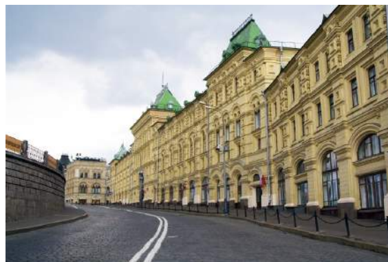
HI-FOG® в здании объекта Красная площадь, дом 5, Москва
